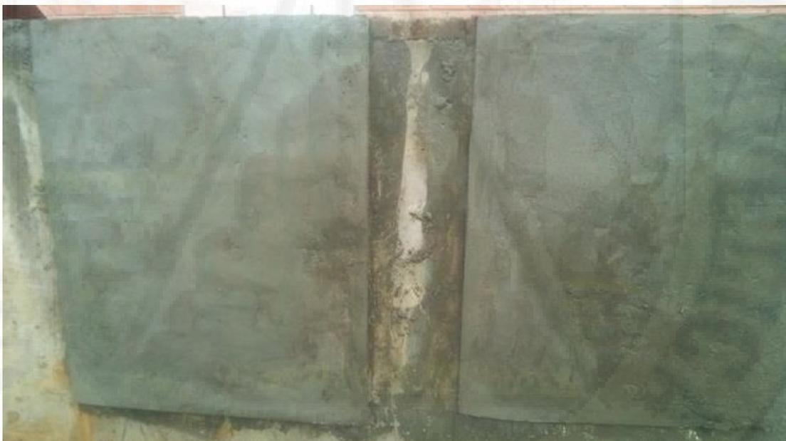
Fotografía 68. Acabado final del revestido con mortero de piedra Checco y mortero de arena fina.
