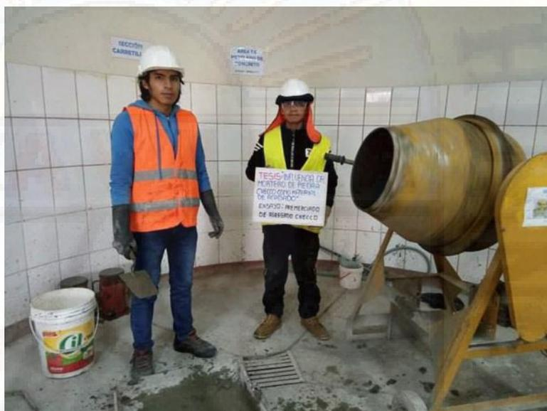
Fotografía 37. Proceso de mezclado de los materiales.
