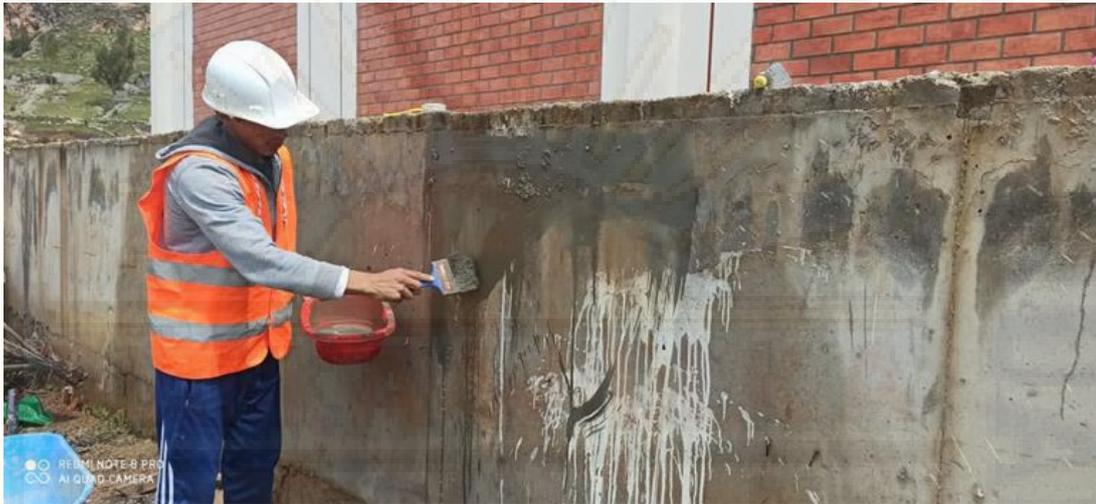
Fotografía 63. Pintarrajeado del muro de aplicación con cemento y agua.
