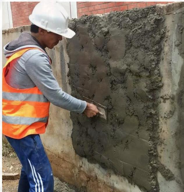
Fotografía 66. Esparcimiento del mortero mediante movimientos circulares.
