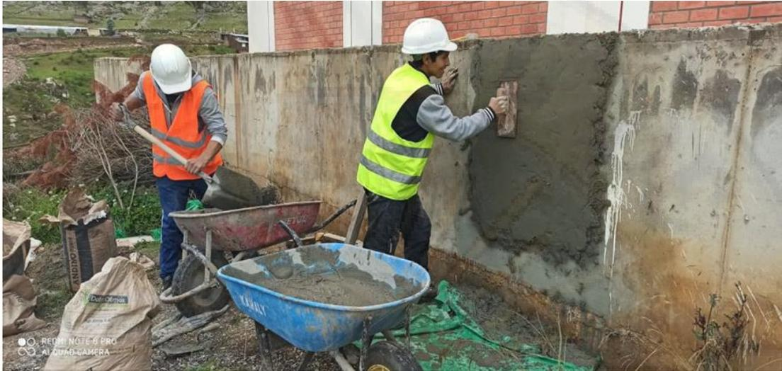
Fotografía 67. Nivelado y acabado final del mortero como material de acabado.
