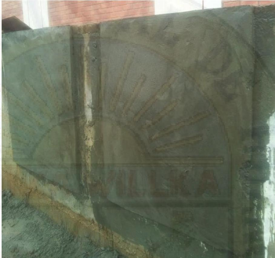
Fotografía 69. Muro de revestido con mortero de piedra Checco y mortero de arena fina.
