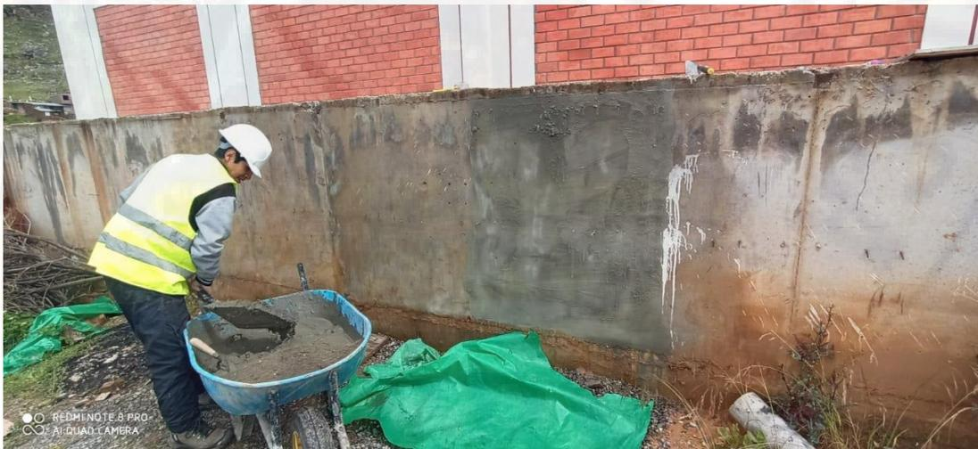
Fotografía 64. Mezcla de los materiales para la conformación del mortero.
