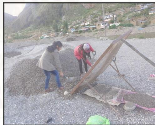
**Fotografía A 5.** Obtención del agregado fino y agregado grueso del Rio Ichu, cantera Callqui Chico – Ascensión - Huancavelica.
