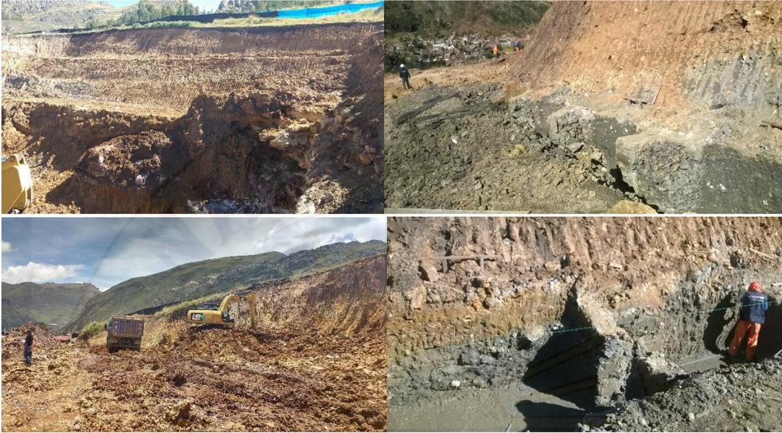
Figura 69: proceso de excavación y cimentación en algunas zonas del deslizamiento de ladera.
