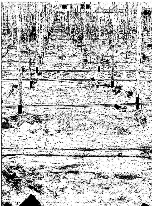
Figura N°4.16. Despliegue de manguera de riego por goteo
