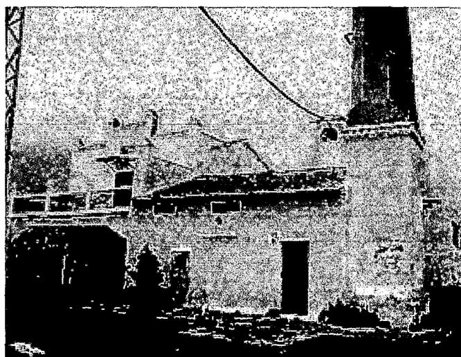
Figura N°2.13. Pou Nou en Catarroja. Este pozo utilizó un motor de vapor — de ahí la chimenea— y fue posteriormente electrificado — obsérvense los cables de suministro—.
